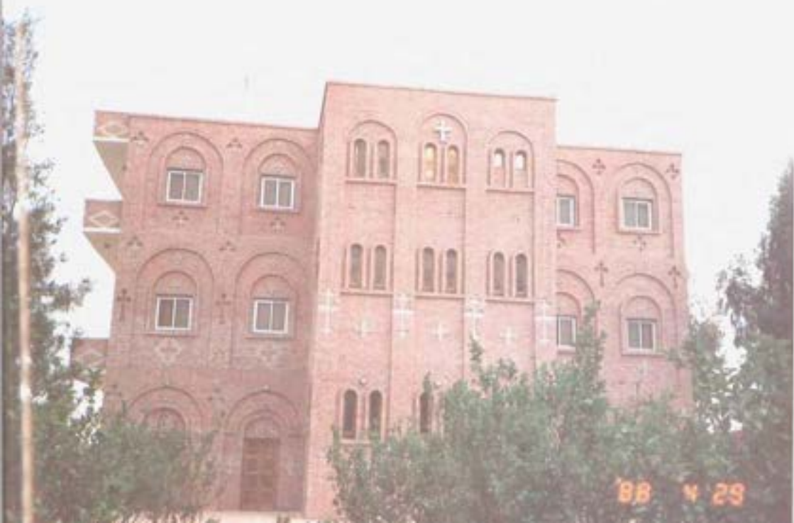
مبنى ضيافة البطارقة ورؤساء الكنائس.
