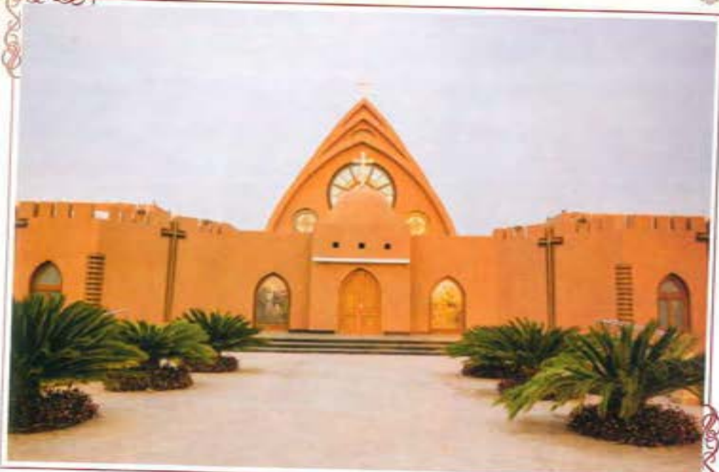
مدخل كنيسة التجلي بمركز لوجوس
